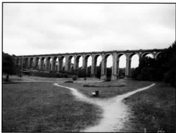
A ponte da Chanca (Lugo), construída na década de 1870, é a maior obra de enxeñería da liña da Coruña a Monforte.
